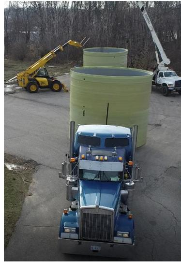
图 1.4.9 米内径复合管道的运输（进行此类运输需要特定路线并获得交通部门许可）
